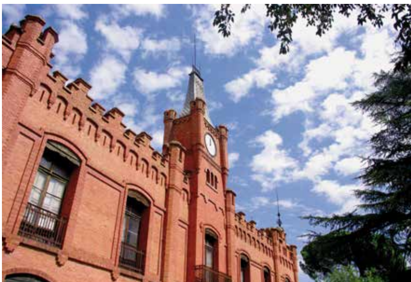
Fachada del palacete de la quinta de Torre Arias con su reloj del siglo XIX.
